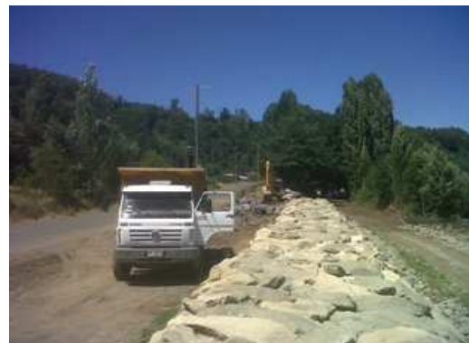
Ejecución de obras de defensas fluviales río Biobío.
