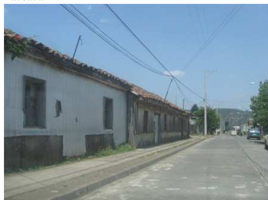
Vivienda de fachada continua en la localidad de Santa Bárbara
