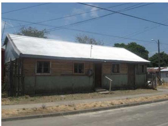
Vivienda sin antejardín sector Santa Bárbara urbano
