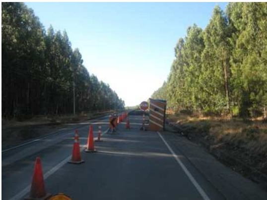
Trabajos de reparación Ruta Q – 61-R
