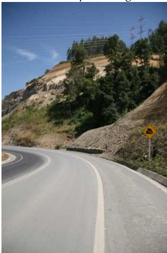
Laderas con pendientes pronunciadas sector construcción represa Angostura
