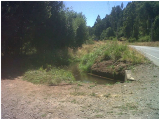
Atraveso canal en Av. Federico Puga.
