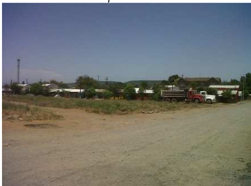
Calle Araucaria sin pavimento
