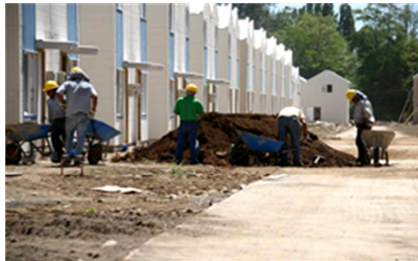
Faenas de construcción de viviendas sociales, localidad Santa Bárbara
