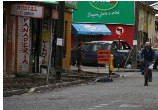
Reparación veredas, localidad Santa Bárbara
